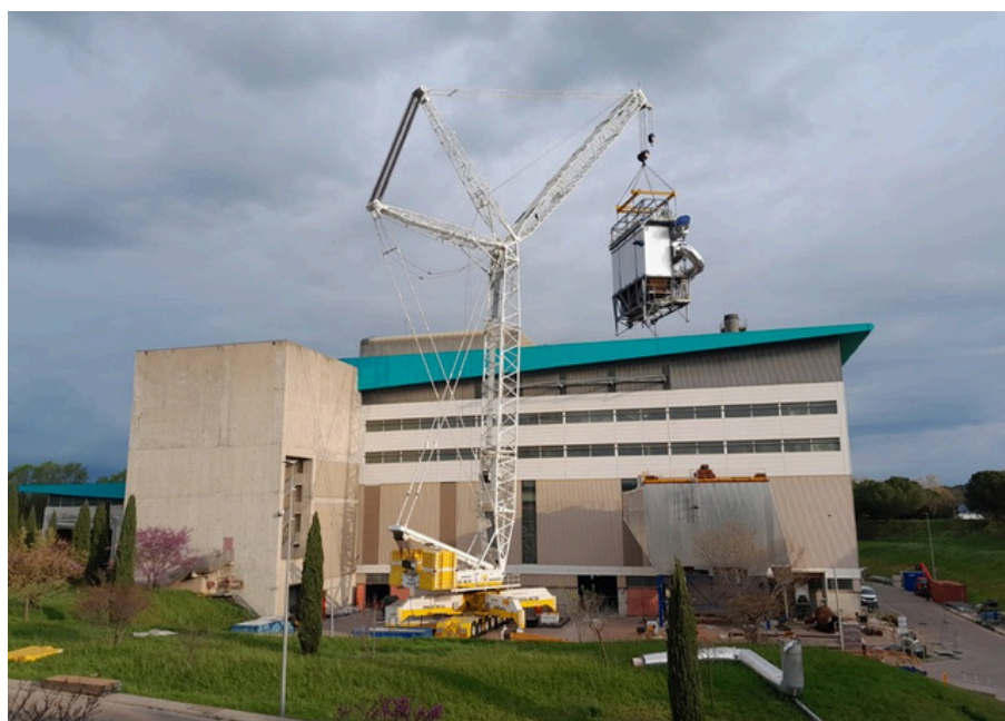
Pose du nouveau filtre à manches sur la deuxième ligne le 2 avril 2025.
