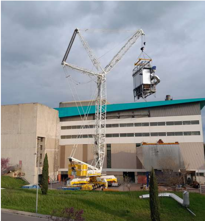
Pose du nouveau filtre à manches sur la ligne de traitement n°1 le 2 avril 2025.
