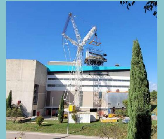
Pose du nouveau filtre à manches sur la ligne deux, le 9 octobre 2024, en remplacement de l'ancien électrofiltre.
