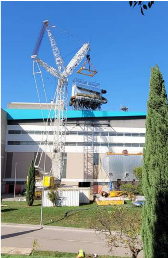
Pose du nouveau filtre à manches le 9 octobre 2024, en remplacement de l'ancien électrofiltre.
