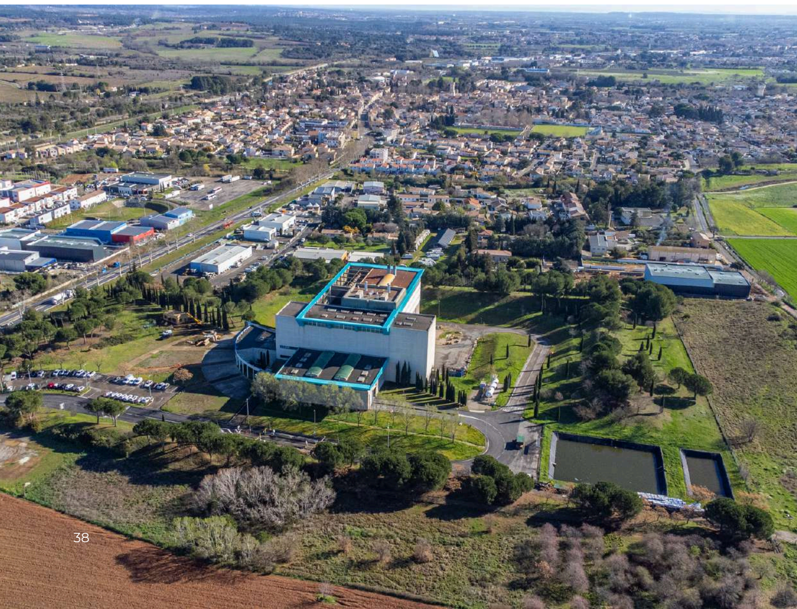
L'Unité de Valorisation Énergétique OCTAV à Lunel-Viel - Crédit Photo : SUEZ
